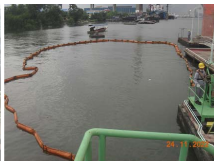
รูปที่ 2.1-6 การซ้อมแผนปฏิบัติงานกรณีรั่วไหลของน้ำมันจากเรือลงสู่แม่น้ำ (แม่น้ำเจ้าพระยา) ขณะเรือเทียบท่า โดยใช้ Oil Fence ซึ่งเป็นทุ่นลอย และมีแผ่นผ้าใบรวมมีความยาว 100 เมตร โดยประมาณ ปิดล้อมสกัดกั้นไม่ให้คราบน้ำมันแพร่กระจายออกไป พร้อมทั้งติดตั้งตัวโรย Boom จำนวน 2 ตัวที่หน้าท่า
