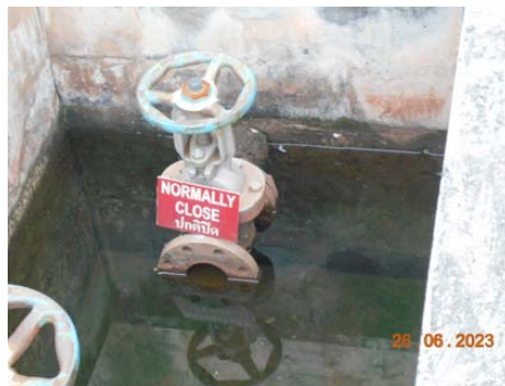
รูปที่ 2.1-2 วาล์วช่องระบายน้ำจะปิดตลอด เพื่อป้องกันน้ำในแม่น้ำเจ้าพระยาไหลย้อนกลับเข้ามาในบ่อแยกน้ำมัน (Oil Separator) ในช่วงเวลาน้ำขึ้น
