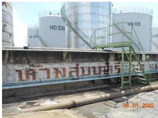
รูปที่ 2.4-4 เขื่อนคอนกรีตเสริมเหล็กโดยรอบ Zone 4 (B-Area)
