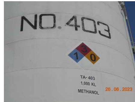
รูปที่ 2.5.3-1 สัญลักษณ์สีท่อนต่างๆ ภายในบริเวณคลังเคมี รูปที่ 2.5.3-2 สัญลักษณ์ NFPA แสดงอันตรายของสารเคมีที่อยู่ในถังเก็บสินค้า
