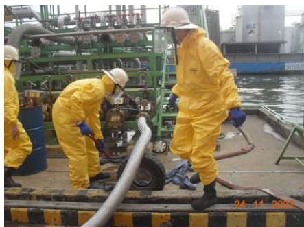
รูปที่ 2.1-6 การซ้อมแผนปฏิบัติงานกรณีรั่วไหลของน้ำมันจากเรือลงสู่แม่น้ำ (แม่น้ำเจ้าพระยา) ขณะเรือเทียบท่า โดยใช้ Oil Fence ซึ่งเป็นทุ่นลอย และมีแผ่นผ้าใบรวมมีความยาว 100 เมตร โดยประมาณ ปิดล้อมสกัดกั้นไม่ให้คราบน้ำมันแพร่กระจายออกไป พร้อมทั้งติดตั้งตัวโรย Boom จำนวน 2 ตัวที่หน้าท่า
