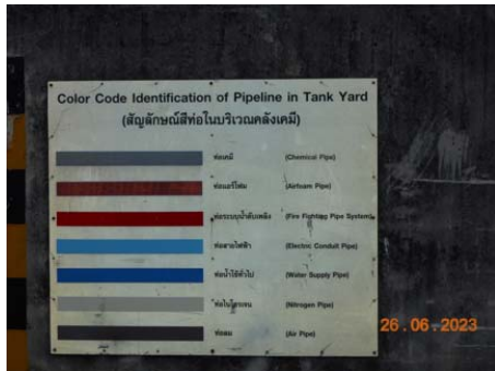
รูปที่ 2.5.3-1 สัญลักษณ์สีท่อนต่างๆ ภายในบริเวณคลังเคมี รูปที่ 2.5.3-2 สัญลักษณ์ NFPA แสดงอันตรายของสารเคมีที่อยู่ในถังเก็บสินค้า
