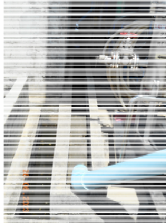
รูปที่ 2.1-4 รางระบายน้ำรอบลานดั่งเคมี (ทุก ZONE) ที่จะเข้าบ่อแยกน้ำมัน (Oil Separator) มีการทำความสะอาด ทุกๆ เดือน หรือในระยะเวลาที่เหมาะสม ถ้าเห็นว่าภายในบ่อมีคราบสกปรก และตะกอนตกค้างมาก เพื่อลดตะกอนและคราบน้ำมันที่จะเข้าสู่ระบบบำบัด
