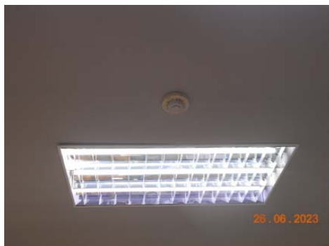
รูปที่ 2.5.3-3 เครื่องตรวจจับความร้อน (Heat detector) รูปที่ 2.5.3-4 ถังแอร์โฟมดับเพลิงภายในโครงการ ไว้ที่เพดานของสำนักงาน
