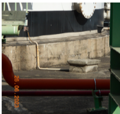
รูปที่ 2.4-2 การทำถังเก็บให้เป็นกลางโดยการต่อสายดินเพื่อป้องกันไฟฟ้าสถิตย์
